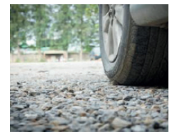
Concassé compacté (Stationnements)
