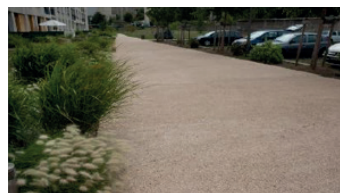
Béton drainant (Cour, circulations piétonnes en pente)
